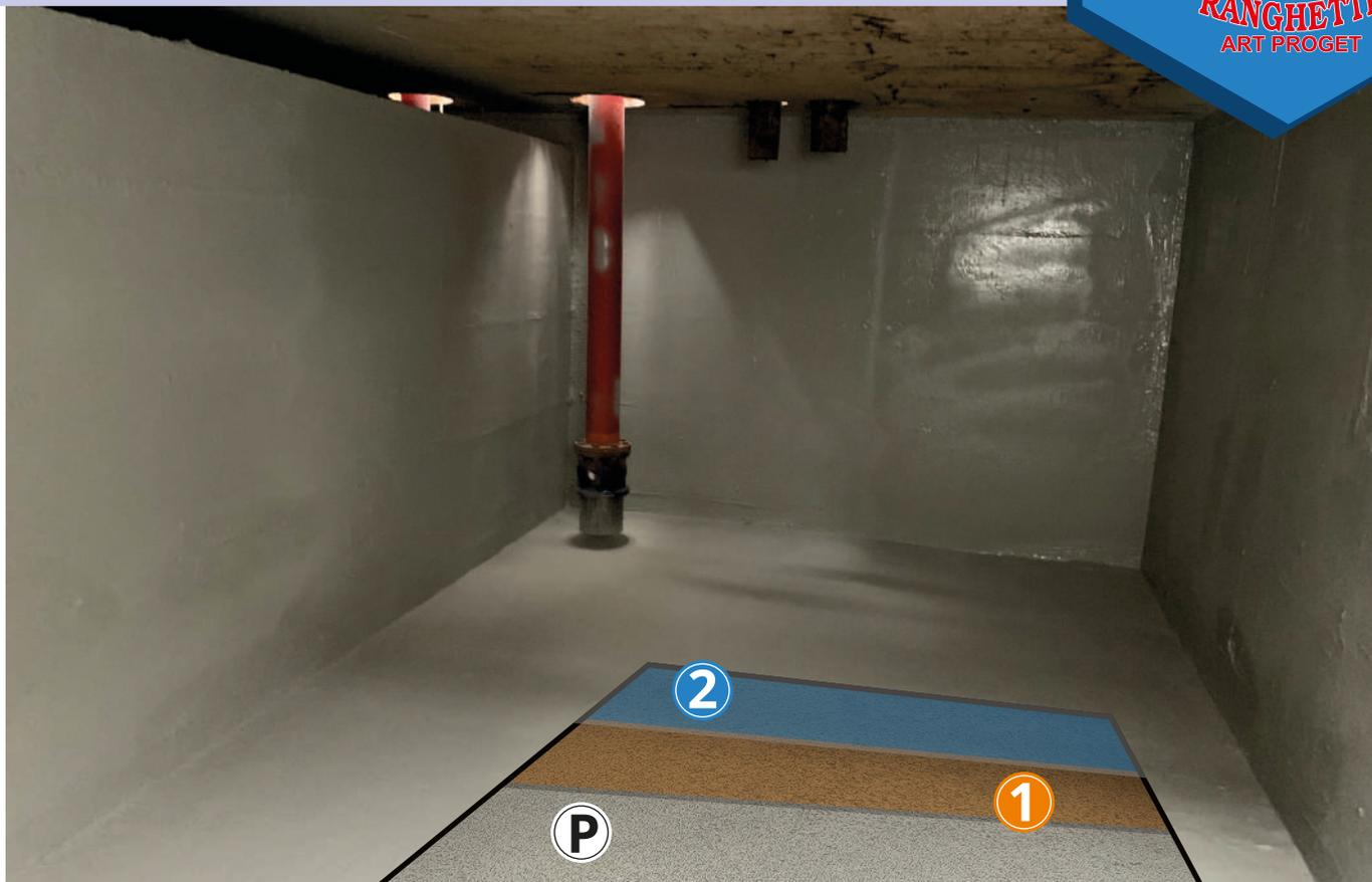
La poliurea a spruzzo Ranghettisol si adatta perfettamente alla struttura esistente e riveste in maniera continua tutta la superficie per creare un'impermeabilizzazione con protezione antiusura e all'abrasione.
